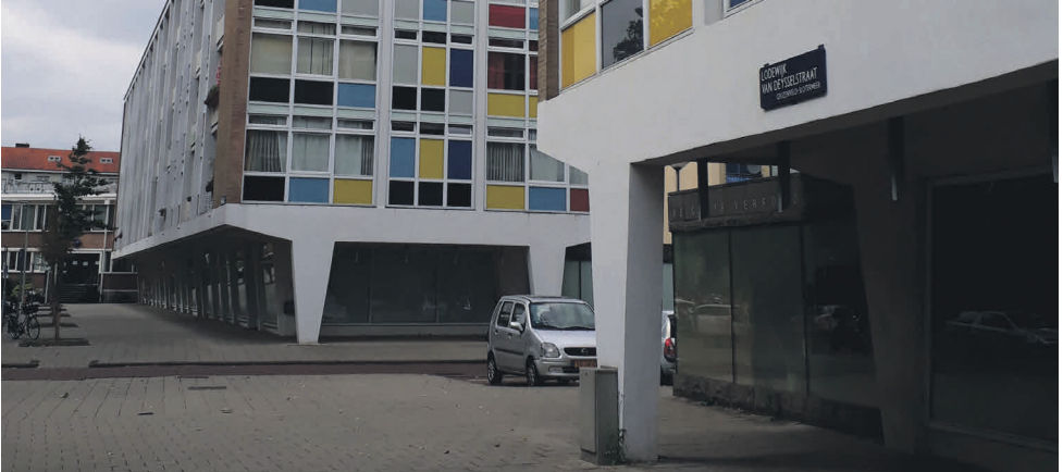
3. Kleurvlakken (1956-1958). Josef Ongenae (1921-1993). Flats (voltooid in 1954) aan de Slotermeerlaan 75-101, Van Moerkerkenstraat 1-15 en Martinus Nijhoffstraat 2-80. Architect: Allert Warners (1914-1981)
