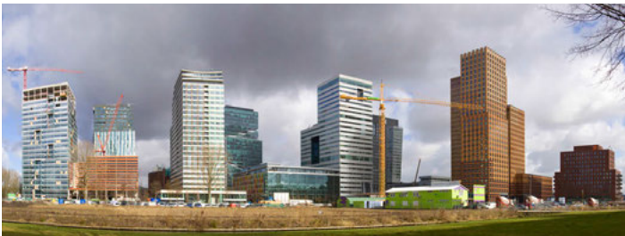
De Zuidas in aanbouw, 2011. Foto Massimo Catarinella
