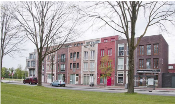
Zelfbouwkavels aan de Troelstralaan. Bron: NUL20
