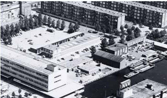
Voormalige stadsreini- gingsdienst met overslag op vuilnisschuiten, Plein 40 - 45.
